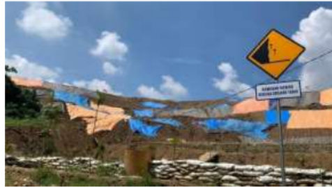
Gambar 2.1 Pemandangan Pengerjaan Proyek pada Bagian Belakang Permukiman Blok F
